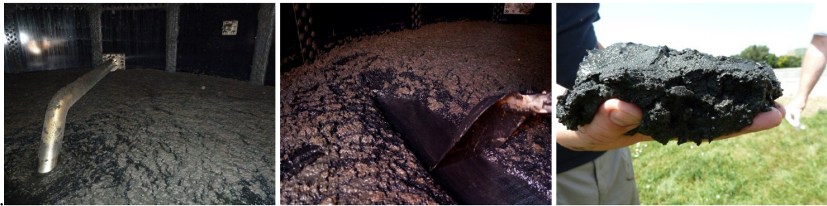
Abbildung 128: Faulbehälter nach Entleerung; links: Innenaufnahme des Faulbehälters; Mitte: Boden des Faulbehälters; rechts: Probe des sedimentierten Materials (Aufnahmedatum: 11.06.2014)
