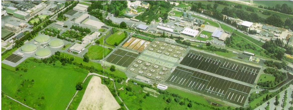
Abbildung 1: Luftbild der Hauptkläranlage-Wien, nach der Inbetriebnahme 1980
