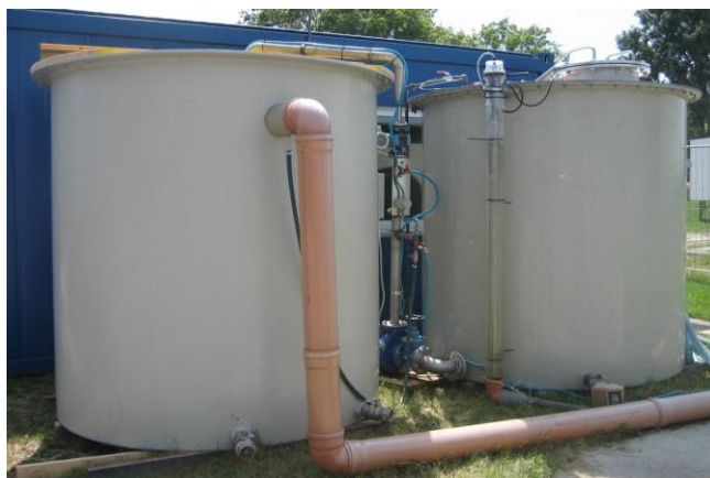
Abbildung 2 Reaktoreinheit: rechts Ozoneintragsbehälter (R1) mit außenliegendem Rohr für Füllstandsmessung, links Reaktionsbehälter (R2) mit oben liegendem Ablaufrohr (Schaar et al., 2011)
