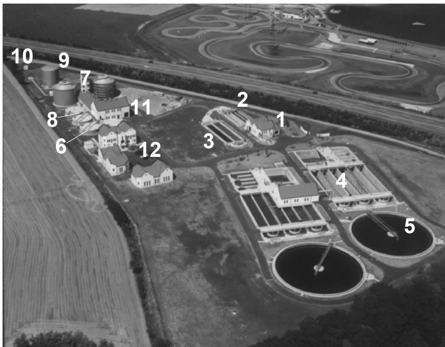
Abbildung 1.1.:Luftbild der Verbandskläranlage Bruck/Leitha-Neusiedl/See
