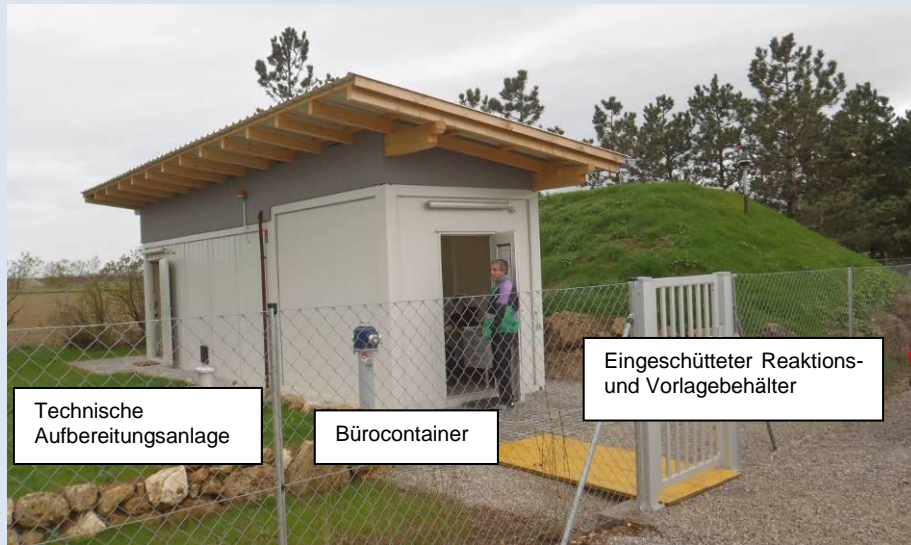
Abbildung 1: Außenansicht Versuchsanlage, Funktionelle Einheiten
