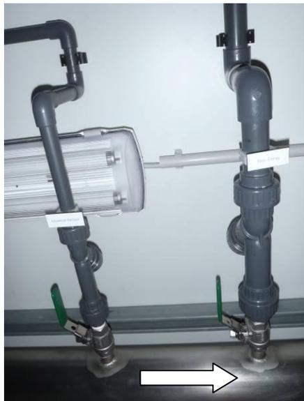
Abbildung 9: Einspeisung von Ozon und Kühlwasserrücklauf in die Hauptleitung
