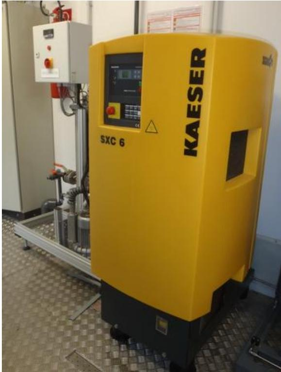
Abbildung 13: Kompressor für Sauerstoffgenerator
