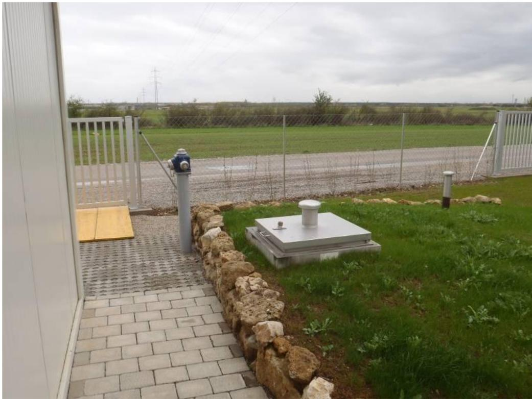
*Abbildung 6: Einlaufschacht mit Schieberkammer*
