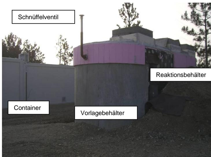
Abbildung 11: Der noch nicht eingeschüttete Reaktions- und Vorlagebehälter; links: Anlagencontainer
