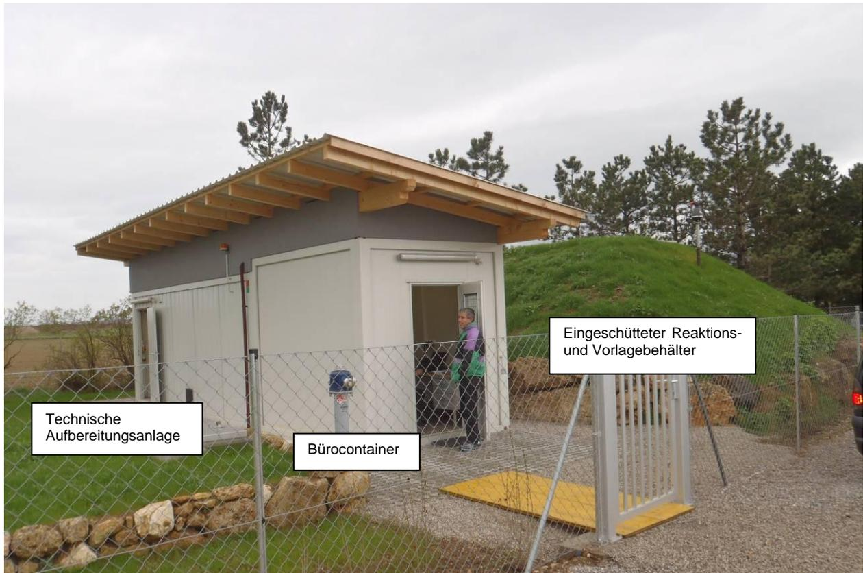
Abbildung 4: Außenansicht Versuchsanlage, Funktionelle Einheiten
