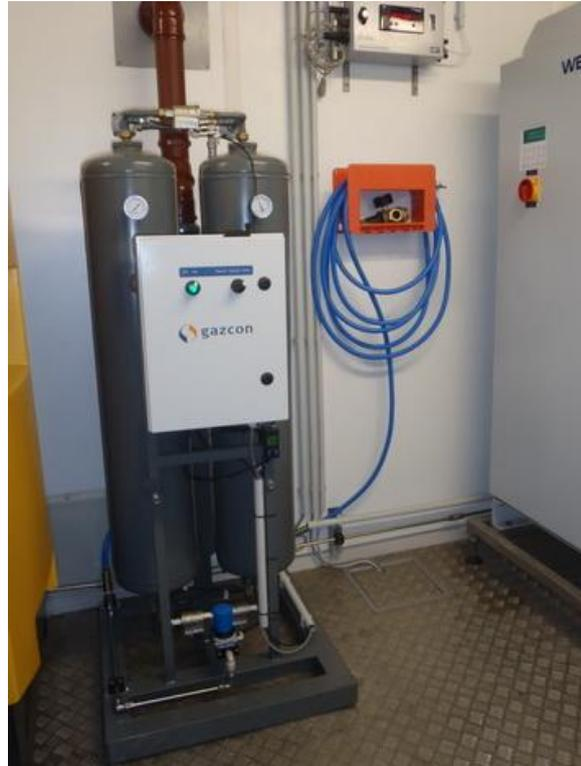
Abbildung 14: Sauerstoffgenerator: PSA-Anlage
