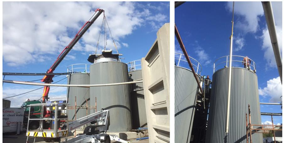
**Bild 3:** Installation der Anammoxreaktoren auf einer 550 000 EW Anlage in Schweden zur Hauptstrombehandlung © Kompetenzzentrum Wasser Berlin gGmbH
